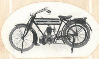
Le pied-support pour l'avant est également fixé au fourreau derrière l'axe, ce qui permet d'enlever la roue avant dans les mêmes conditions que celle d'arrière.
